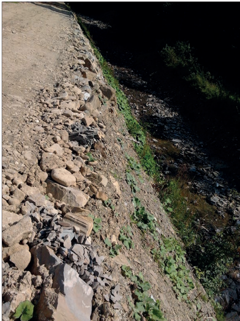
Fot. 2. Widok na podniesioną skarpe potoku
